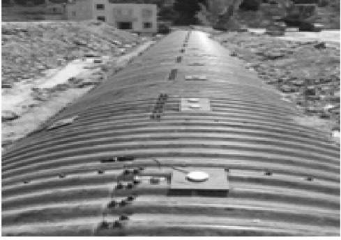
图 5 土压力盒的现场埋设
