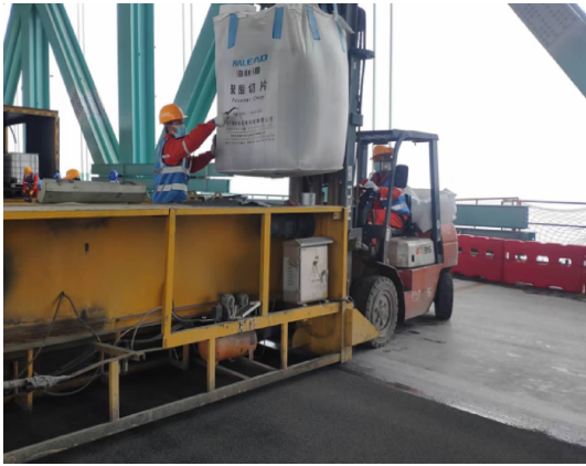
图 8 玄武岩碎石撒布 Fig.8 Basalt rubble spread
