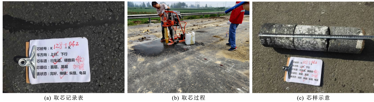
图 1 现场取芯 Fig. 1 On-site coring
