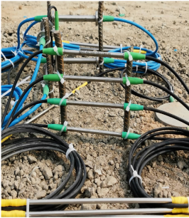
(b) 传感器布设施工
