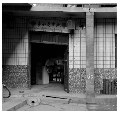
图 3 堡子村遭受地裂缝破坏的建筑物(镜向:东)
