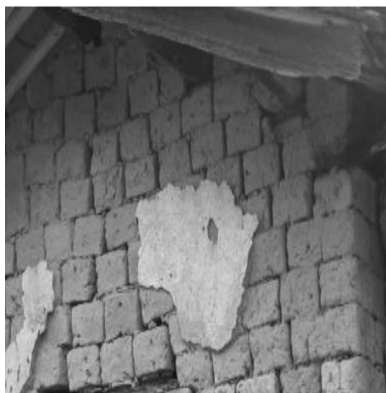
图 6 平砌土坯墙
