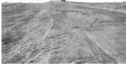
图 6 积水取土坑引发的路基弧形裂缝
