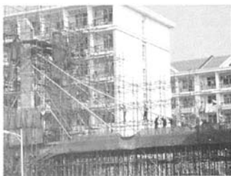
图3 CFRP 拉索的安装
