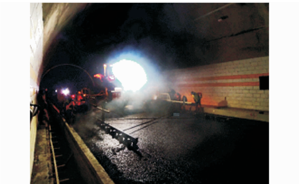
图 3 采用温拌工艺后,隧道路面摊铺时白烟有所缓和
