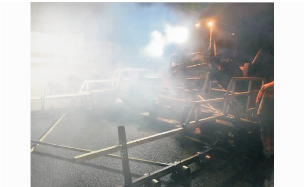
图 2 隧道路面热拌铺筑时产生的白烟
