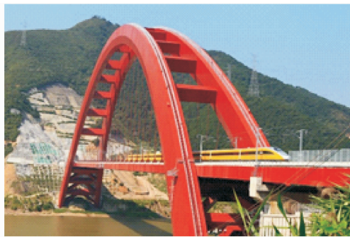
图5 现场测试照片
