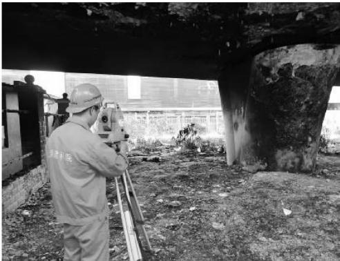
图 9 全站仪进行主梁变形监测
