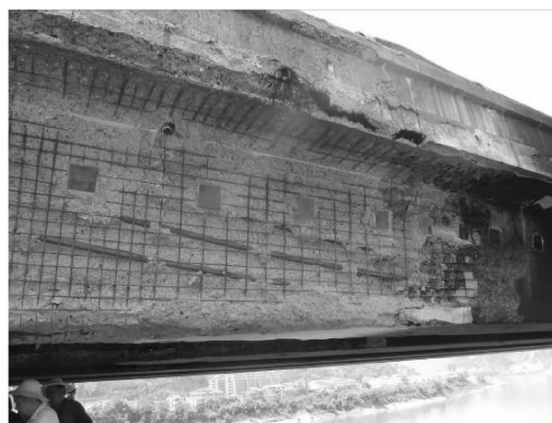
(a) 混凝土深度爆裂(负弯矩区)
